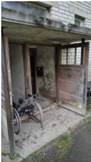
Kāpņu telpas ārdurvis
